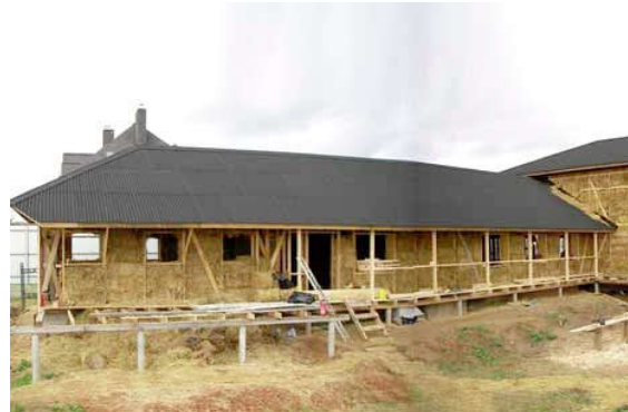
Ngôi nhà sinh thái “Freedom” với tường xây bằng rơm rạ ép tại Vùng Moskva (Nga)
